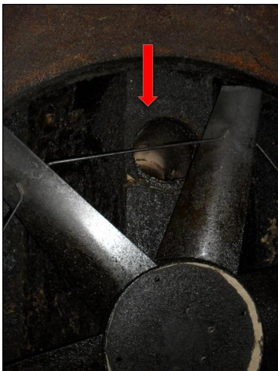
Figura 13 – Sistema de circulação de ar – damper.
