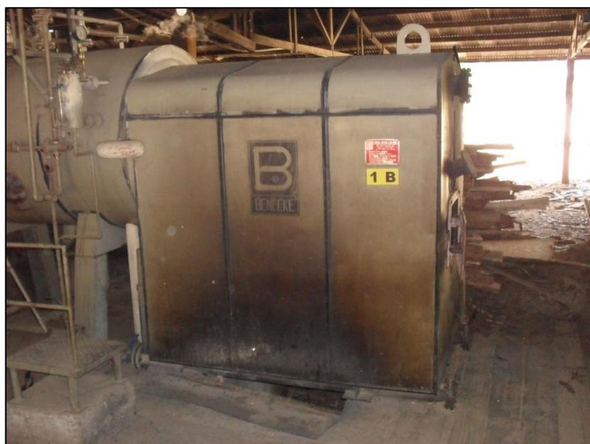
Figura 11 – Sistema de aquecimento – caldeira para geração de vapor.
