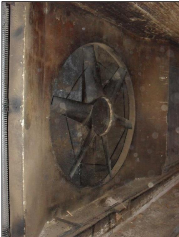
Figura 12 – Sistema de circulação de ar – ventilador.
