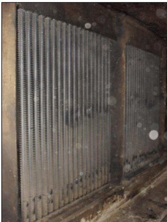
Figura 10 – Sistema de aquecimento – trocadores de calor tipo tubos aletados.
