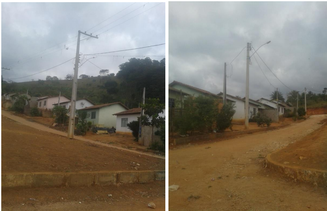
Figura 6. Casas no loteamento Boa Fé com erosão acentuada Fonte: Próprio autor.
