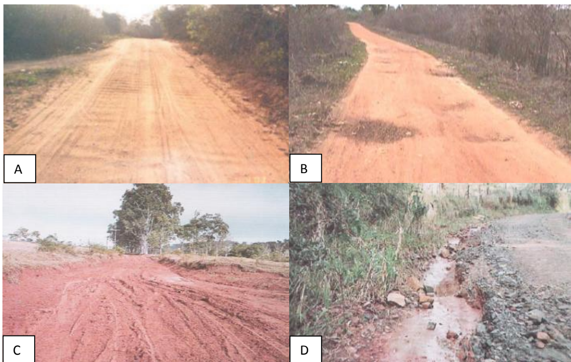
Figura 2 - Problemas nas estradas florestais. A: Ondulações ou “costela de vaca”. Fonte: (MOREIRA, 2003). B: Seção transversal inadequada. Fonte: (BAESSO, 2003). C: Mau funcionamento do sistema de drenagem superficial. Fonte: (BAESSO, 2003). D: – Ocorrência de buracos. Fonte: (MOREIRA,2003).
