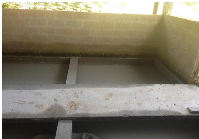
Figura 25 – Sistema de decantação
