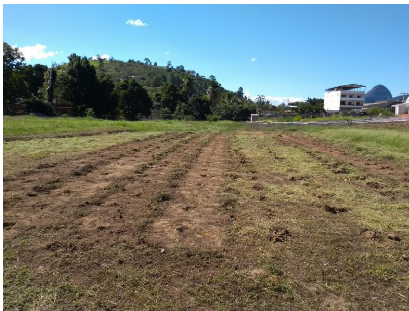
Figura 3 - Limpeza da área e marcação dos berços. Fonte: O autor (2019).
