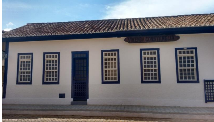
Figura 49 – Edificação 12 – Vista da fachada.
