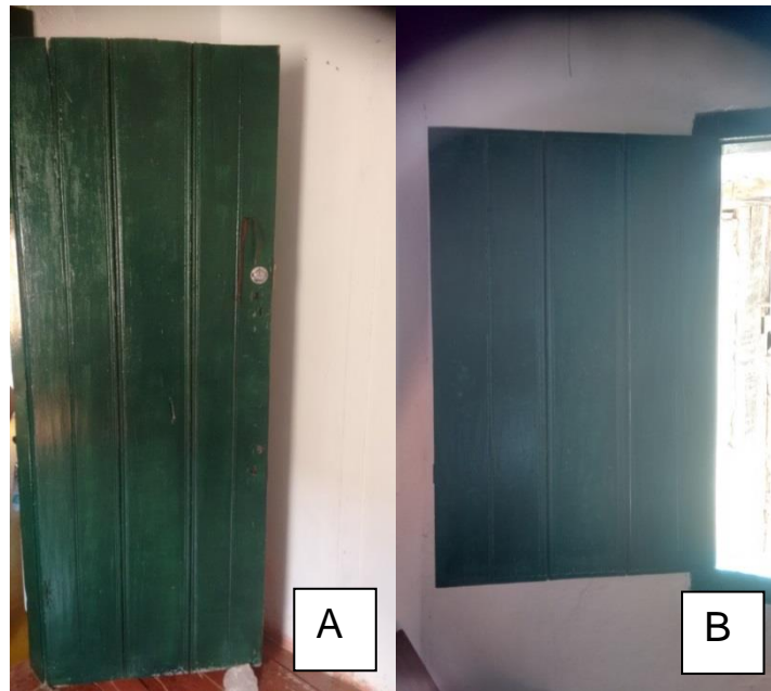
Figura 60 – Edificação 14: A – Porta de entrada, B – Vista interna da janela. Fonte: O autor (2016).
