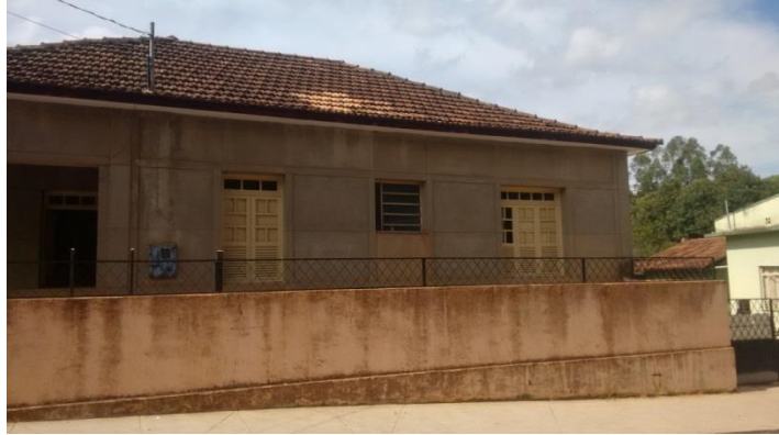
Figura 44 – Edificação 11 – Vista da fachada.
