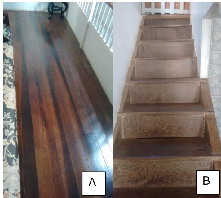
Figura 26 – Edificação 07: A – Piso, B – Escada. Fonte: O autor (2016).
