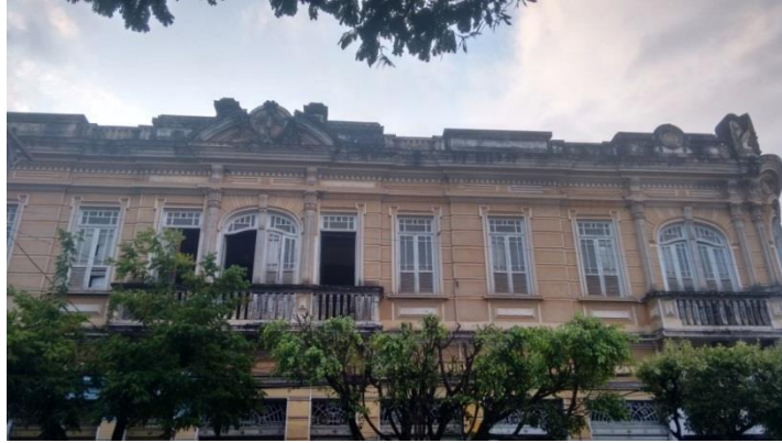
Figura 20 – Edificação 06 – Vista da fachada.
