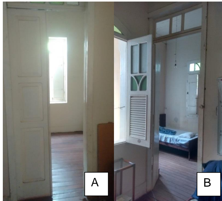
Figura 33 – Edificação 08: A – Vista interna da porta, B – Vista interna da janela. Fonte: O autor (2016).
