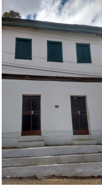
Figura 58 – Edificação 14 – Vista da fachada.
