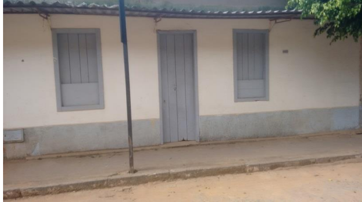
Figura 30 – Edificação 08 – Vista da fachada.
