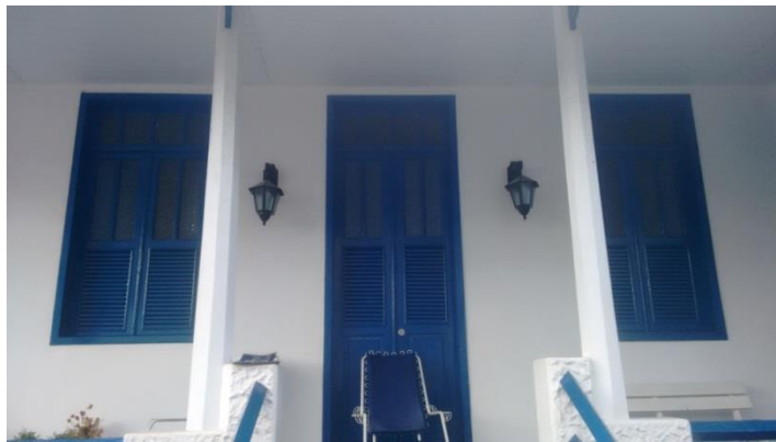
Figura 37 – Edificação 09 – Vista externa da janela.
