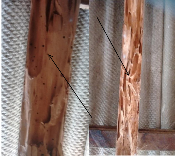
Figura 63 – Edificação 15 – Caibros atacados por cupins e brocas (setas indicativas). Fonte: O autor (2016).
