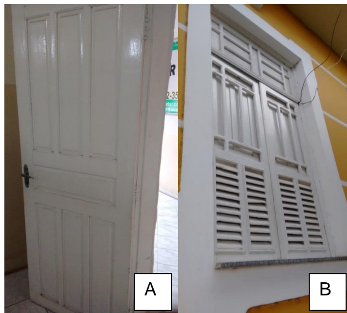
Figura 18 – Edificação 05: A – Porta de entrada, B – Vista externa da janela.
