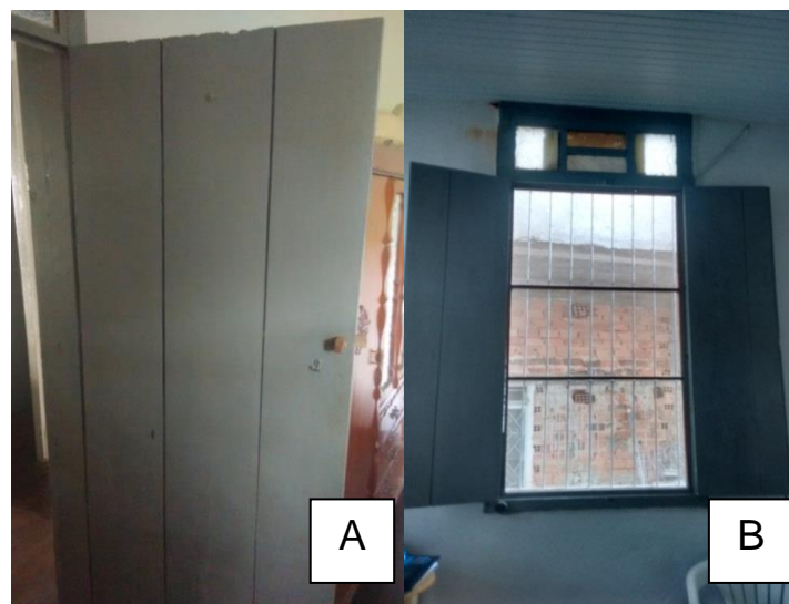
Figura 12 – Edificação 03: A – Porta interna, B – Vista interna da janela.
