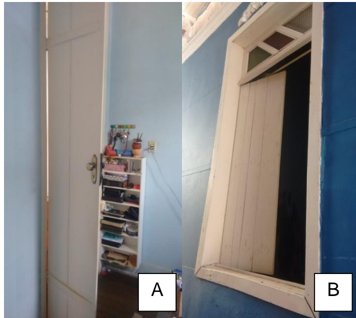
Figura 7 – Edificação 02: A – Porta entrada, B – Vista externa da janela.
