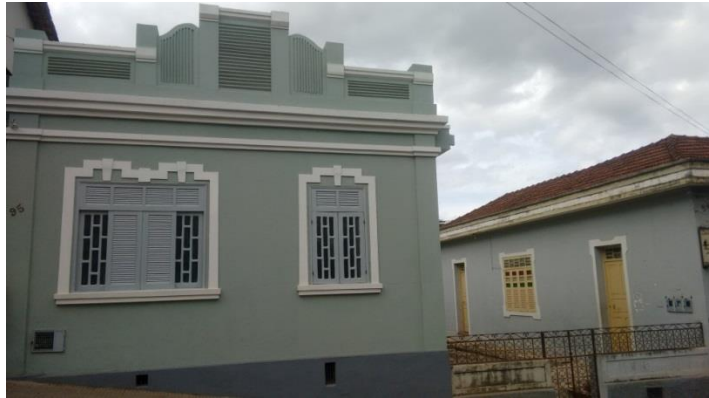
Figura 39 – Edificação 10 – Vista da fachada.
