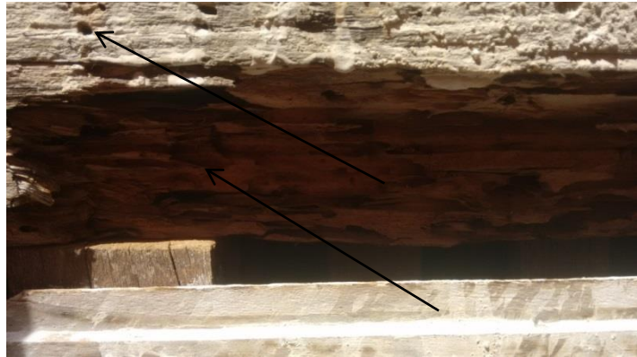
Figura 53 – Edificação 13 – Viga atacada por cupins e brocas (setas indicativas).
