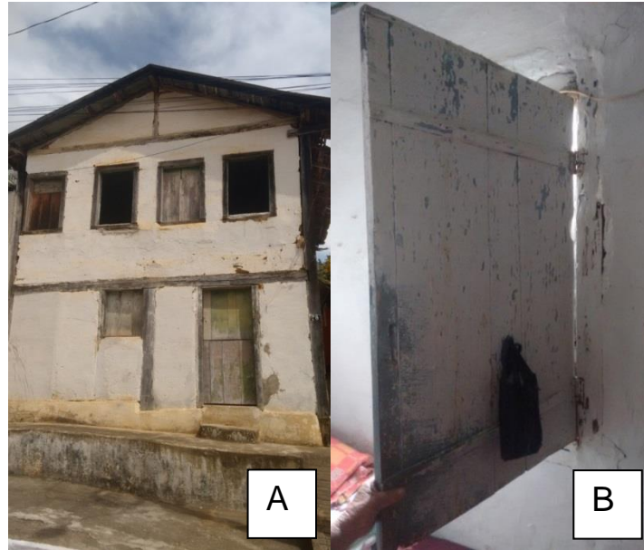
Figura 57 – Edificação 13: A – Vista externa da porta, B – Vista interna da janela. Fonte: O autor (2016).
