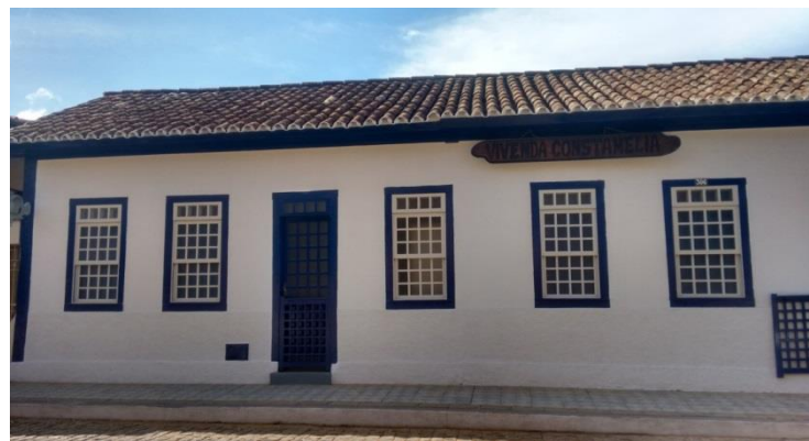
Figura 52 – Edificação 12 – Vista externa da janela.
