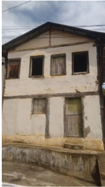
Figura 55 – Edificação 13 – Vista da fachada.
