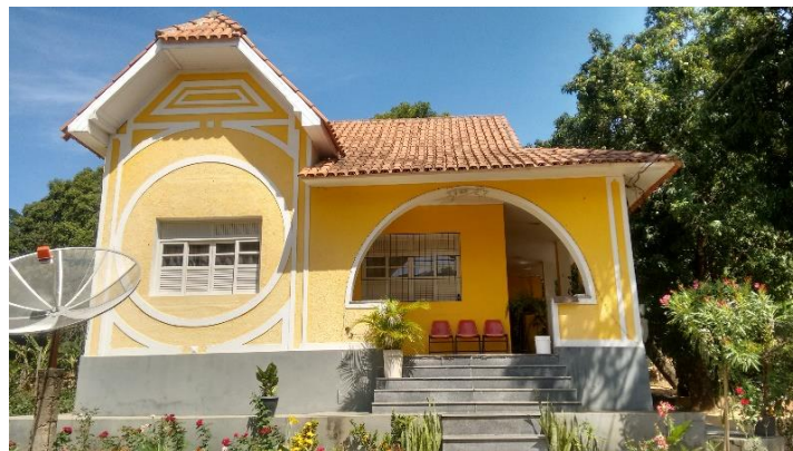
Figura 1 – Edificação 01 - Vista da fachada.
