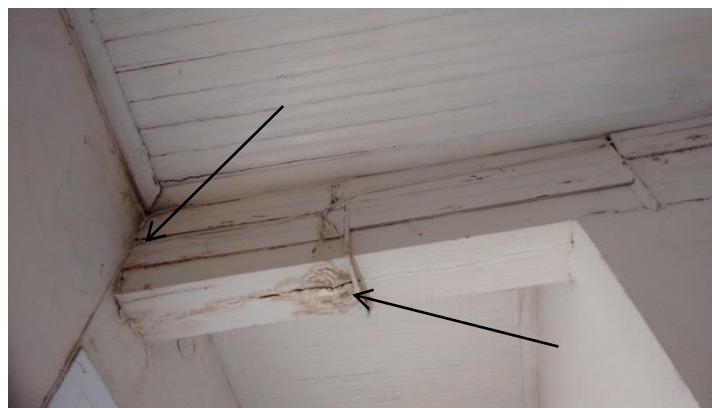
Figura 13 – Edificação 04 – Forro com pontos de umidade (Setas indicativas).
