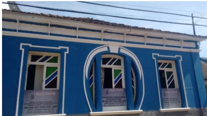
Figura 4 – Edificação 02 – Vista da fachada.
