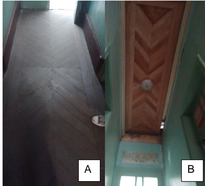
Figura 22 – Edificação 06: A – Piso, B – Forro após reforma.
