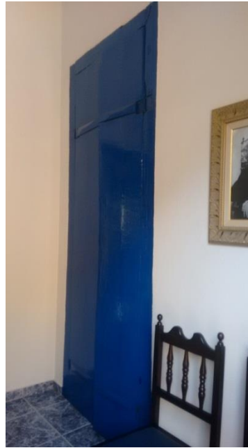
Figura 51 – Edificação 12 – Vista interna da porta.
