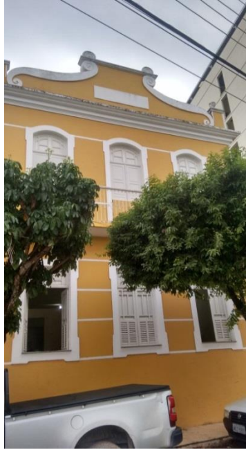
Figura 17 – Edificação 05 – Vista da fachada.
