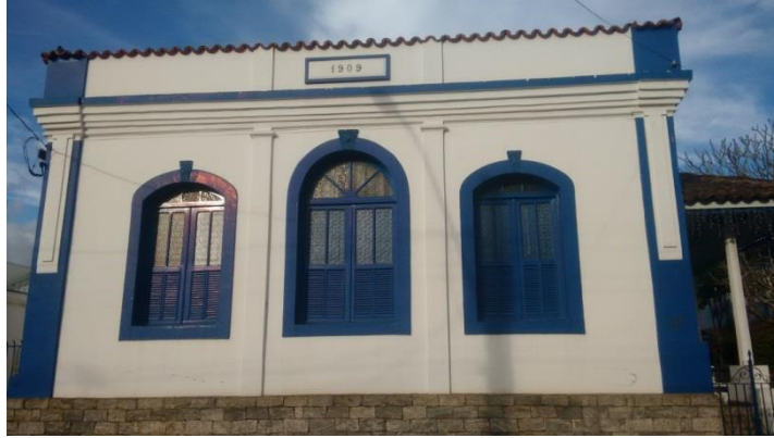
Figura 34 – Edificação 09 – Vista da fachada.
