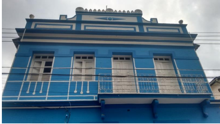
Figura 14 – Edificação 04 – Vista da fachada.
