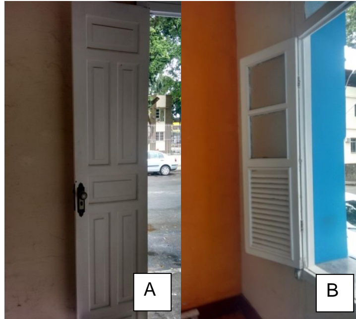
Figura 16 – Edificação 04: A – Porta de entrada, B – Vista interna da janela.
