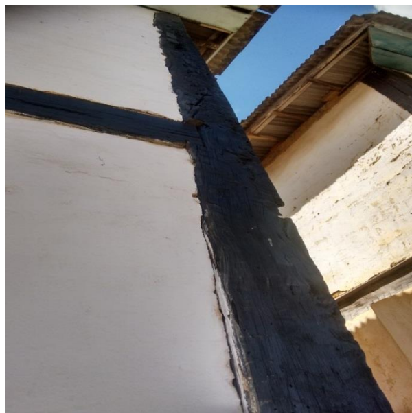
Figura 61 – Edificação 14 – Vigas e pilares. Fonte: O autor (2016).
