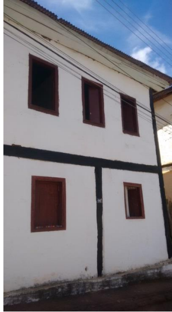
Figura 65 – Edificação 15 – Vista da fachada.
