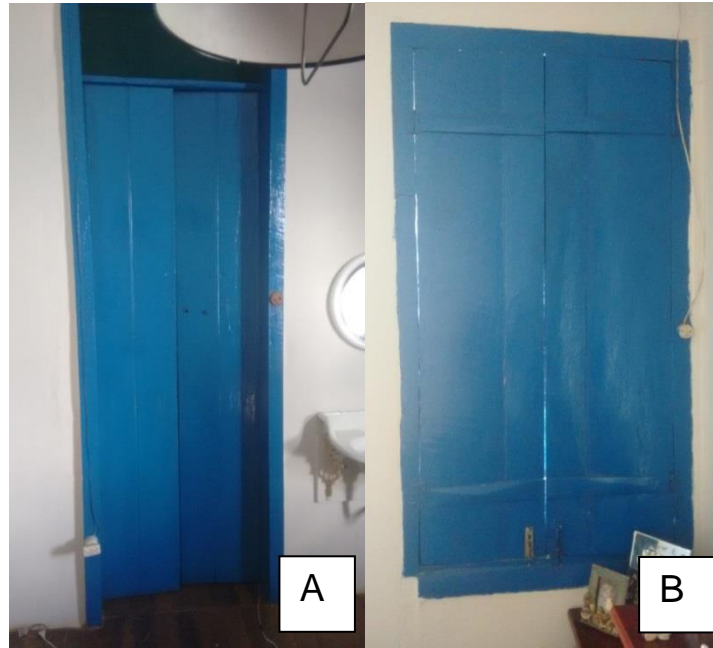
Figura 25 – Edificação 07: A – Vista interna da porta, B – Vista interna da janela. Fonte: O autor (2016).
