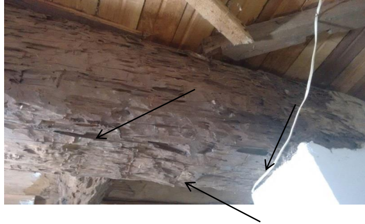
Figura 23 – Edificação 07 – Barrote atacado por cupins (setas indicativas). Fonte: O autor (2016).
