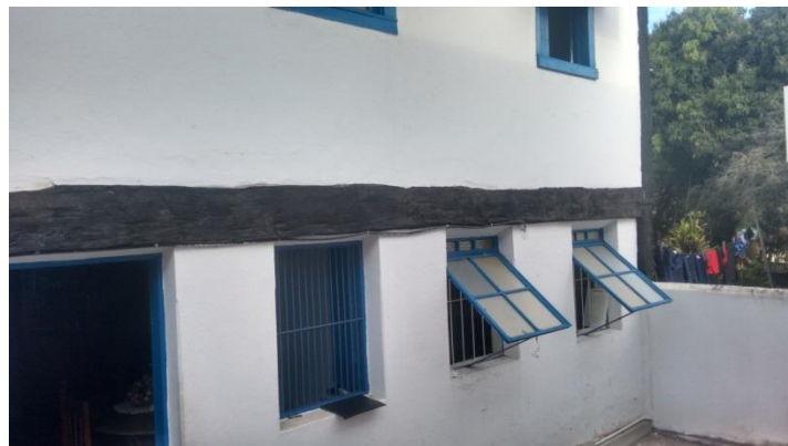
Figura 28 – Edificação 07 – Viga. Fonte: O autor (2016).
