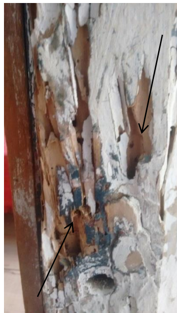
Figura 54 – Edificação 13 – Batente da porta atacado por cupins e brocas (setas indicativas).
