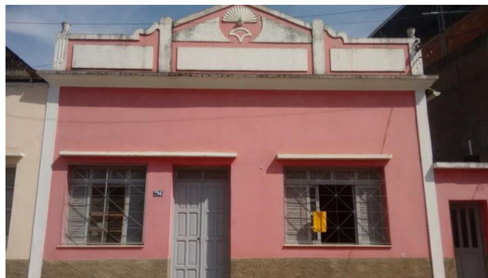
Figura 9 – Edificação 03 – Vista da fachada. Fonte: O autor (2016).
