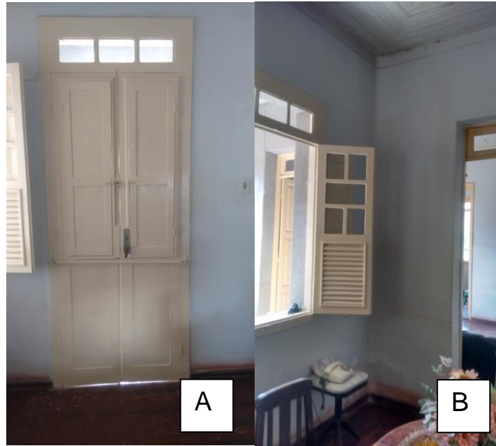
Figura 46 – Edificação 11: A – Vista interna da porta, B – Vista interna da janela. Fonte: O autor (2016).
