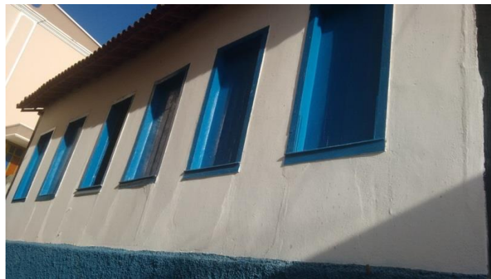
Figura 24 – Edificação 07 – Vista da fachada. Fonte: O autor (2016).
