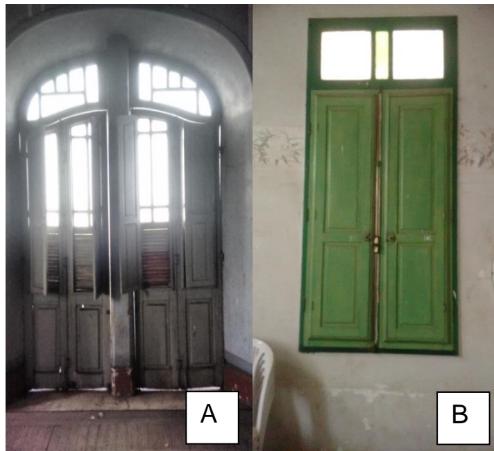
Figura 21 – Edificação 06: A – Vista interna da porta, B – Vista interna da janela.
