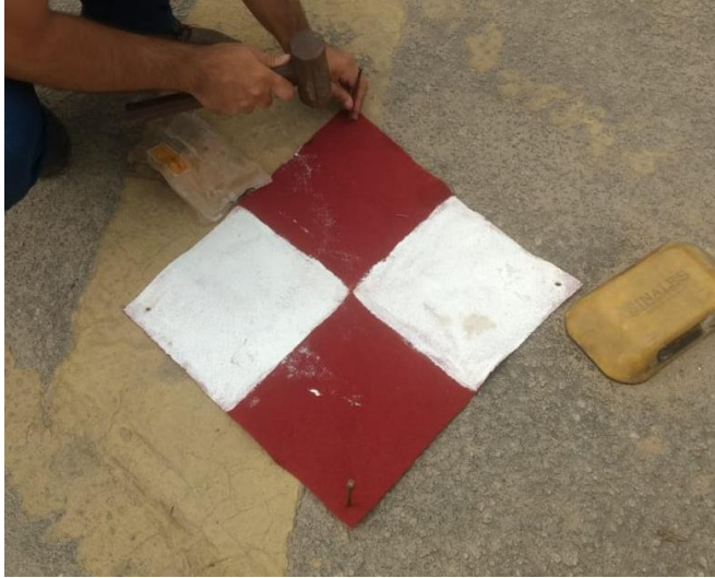
Figura 6. Tapete utilizado para coleta do ponto de controle.
