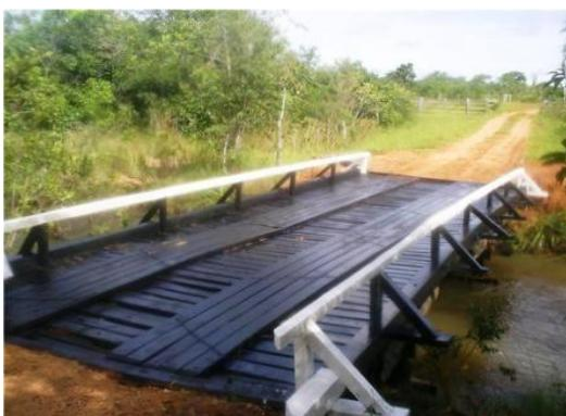
Figura 2.4 – Ponte de peças serradas
