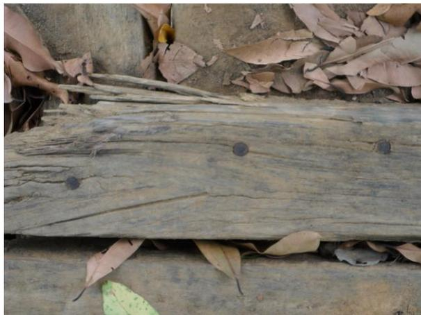
Figura 3.9 – Elementos de ligação das ponte 1.
