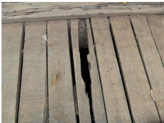
Figura 4.6 – Danos causados devido abrasão e as sobrecargas no tabuleiro na ponte 3.
