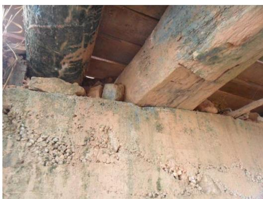
Figura 4.1 – Longarinas em base de concreto ponte 2.
