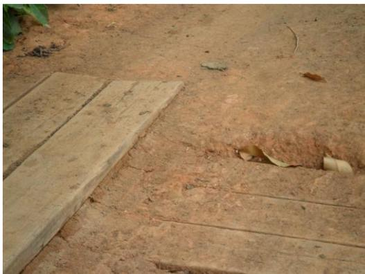
Figura 4.2 – Extremidade em contato direto com a terra na ponte 2.
