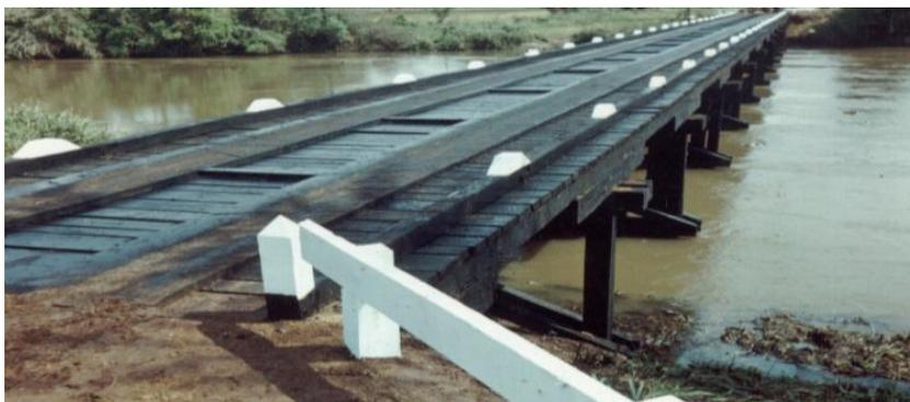
Figura 2.3 – Ponte de vigas simples
