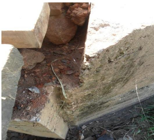
Figura 4.7 – Fundação de concreto para sustentação da ponte 2.
