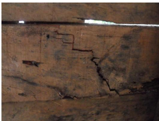
Figura 4.5 – Esforços de cisalhamento da ponte 2.
