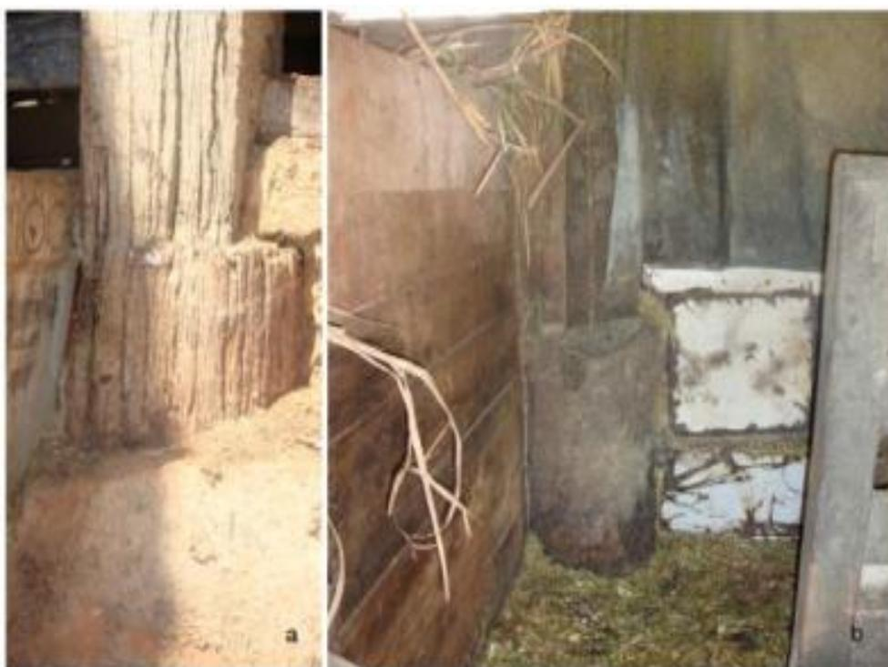
Figura 24 – a: Esteio lateral com fundação na forma de nabo afetado pela lixiviação do solo ou por agentes deterioradores; b: Esteio lateral com fundação na forma de nabo intacta.
