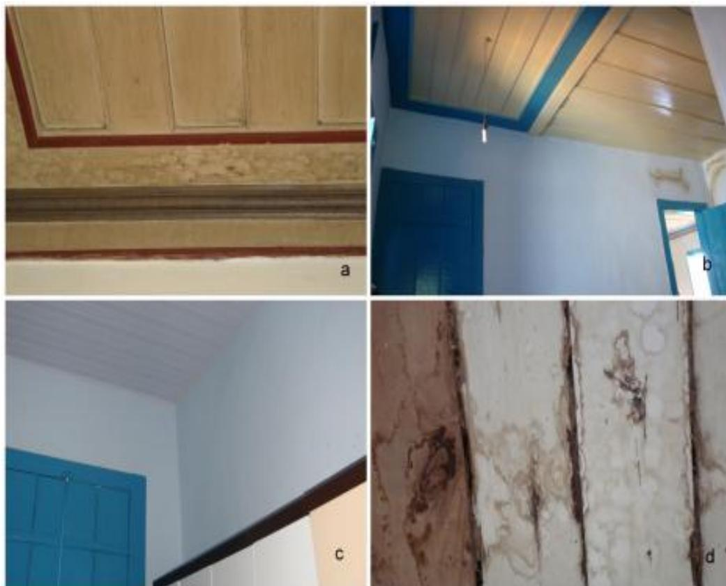
Figura 20 – a e b: Forro no estilo saia e camisa; c: Forro de PVC; d: Forro atacado por cupim.
