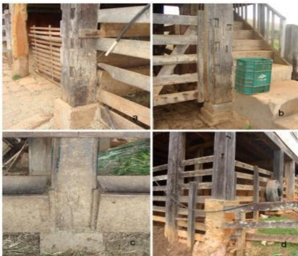
Figura 25 – a, b e c: Esteio lateral intervindo devido à deterioração da fundação; d: Esteio do interior da casa modificado devido à alta umidade do solo.
