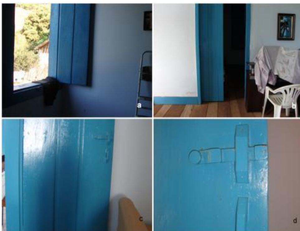
Figura 21 – a: Janela; b: Porta 1; c: Porta 2; d: Detalhe construtivo da fechadura em madeira.
