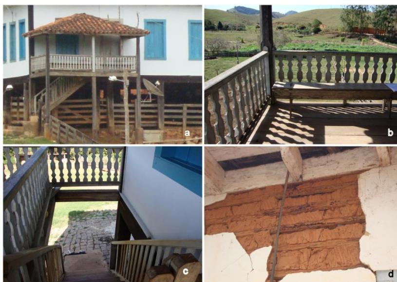
Figura 18 – a, b e c: Alpendre; d: Alvenaria de pau a pique.
