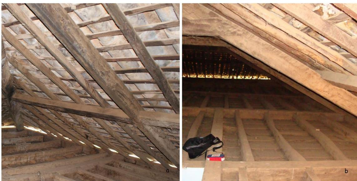
Figura 38 – a: Encaixe da terça com a asna; b: encaixe da terça com a cantalha.
