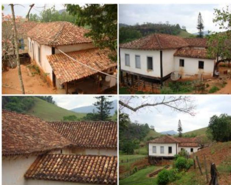
Figura 15 – Vista do telhado em telhas do tipo capa e canal.
