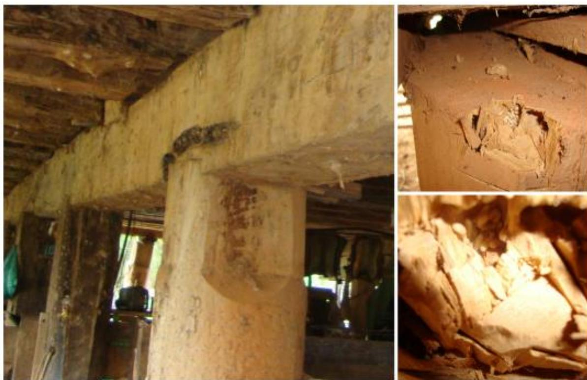
Figura 53 – Esteio atacado por *Cryptotermes brevis*.
