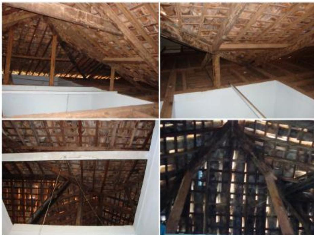
Figura 17 – Estrutura do telhado no encontro entre as partes frontal e lateral.
